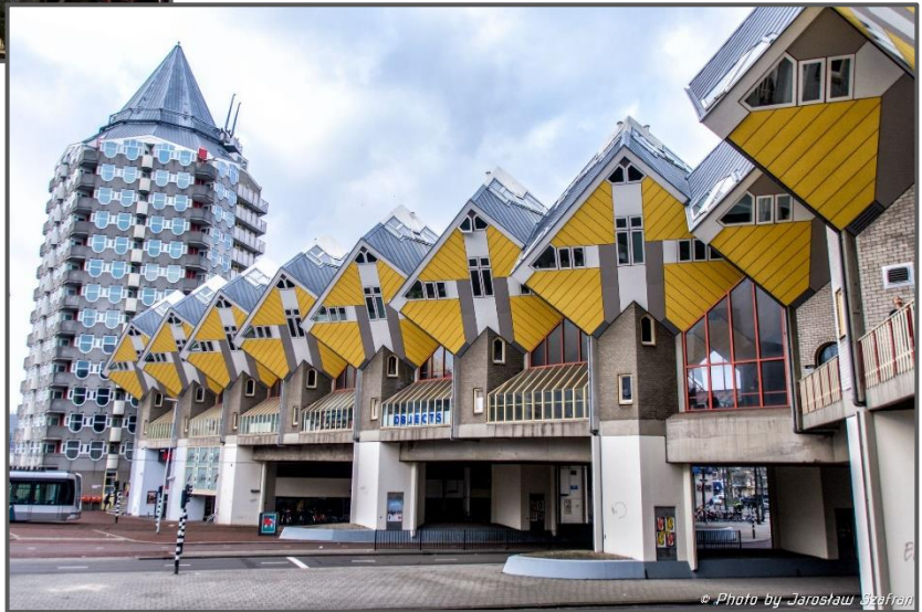
Figure 8a: Piet Blom, The Cube Houses (Kubuswoningen) , Rotterdam, 1975 - 1977.
